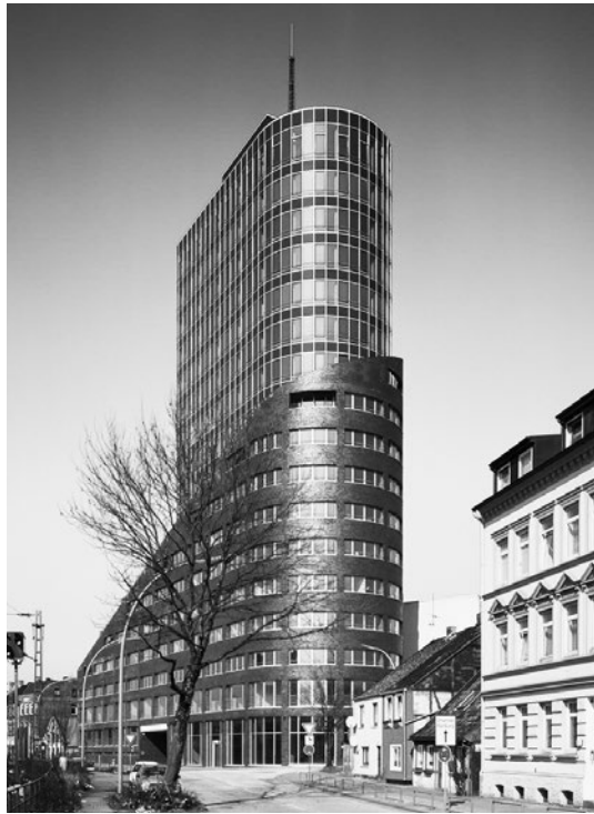
Der von Bernhard Winking entworfene Channel Tower in Harburg; Foto: Winking Froh Architekten
