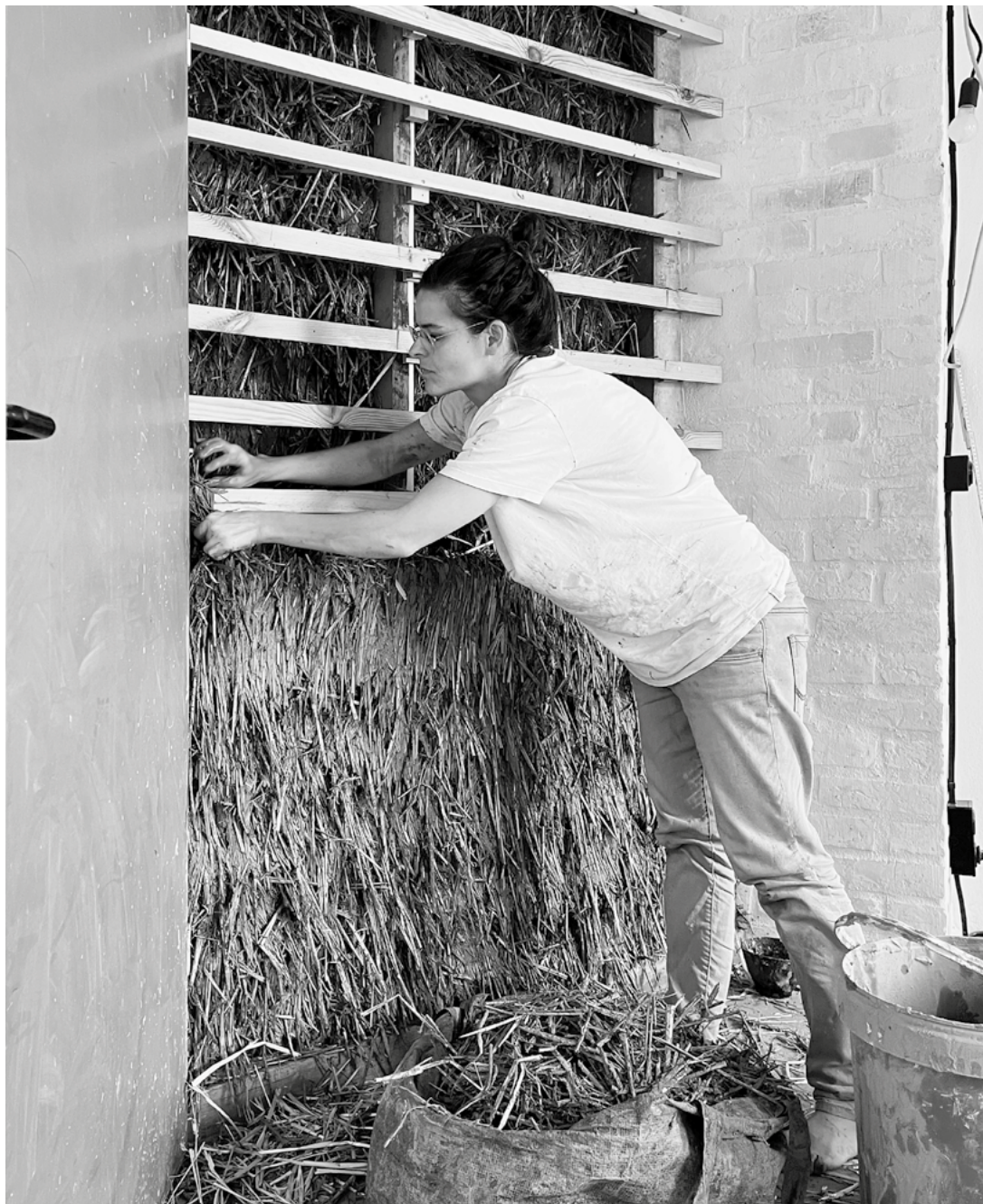
Anne Femmer an der Sandsteinreparatur von Fensterbögen und bei der Erstellung einer Strohleichtlehmwand; Foto: Florian Summa
